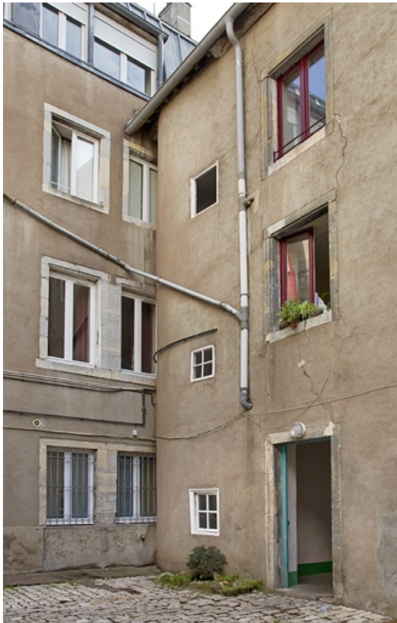
Deuxième logis secondaire : vue d'ensemble, de trois quarts droit.
