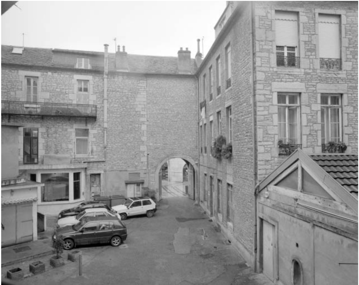
Vue de la cour antérieure depuis le logis sur cour, de trois quarts droit.
