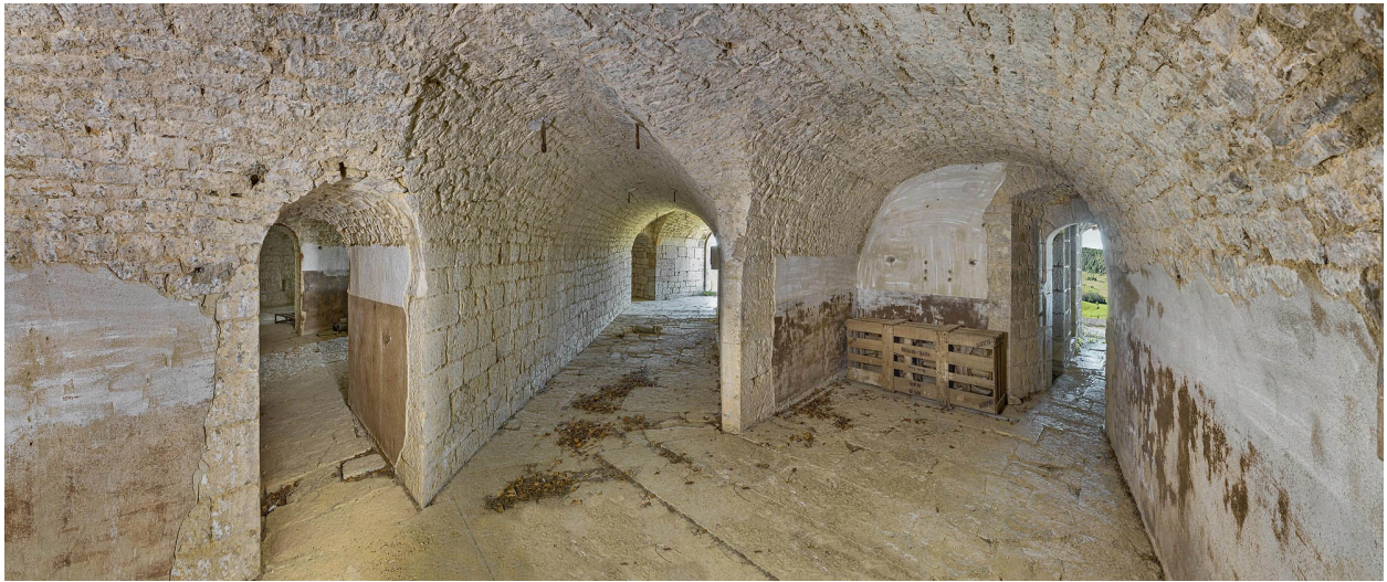
Salles casematées de l'étage vouté (en berceau segmentaire).
