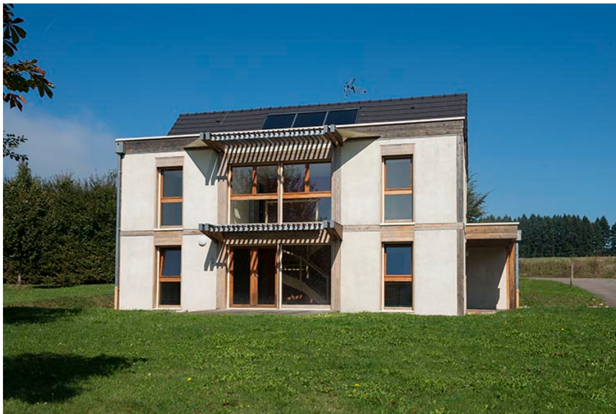
Façade sud de la maison verte.
