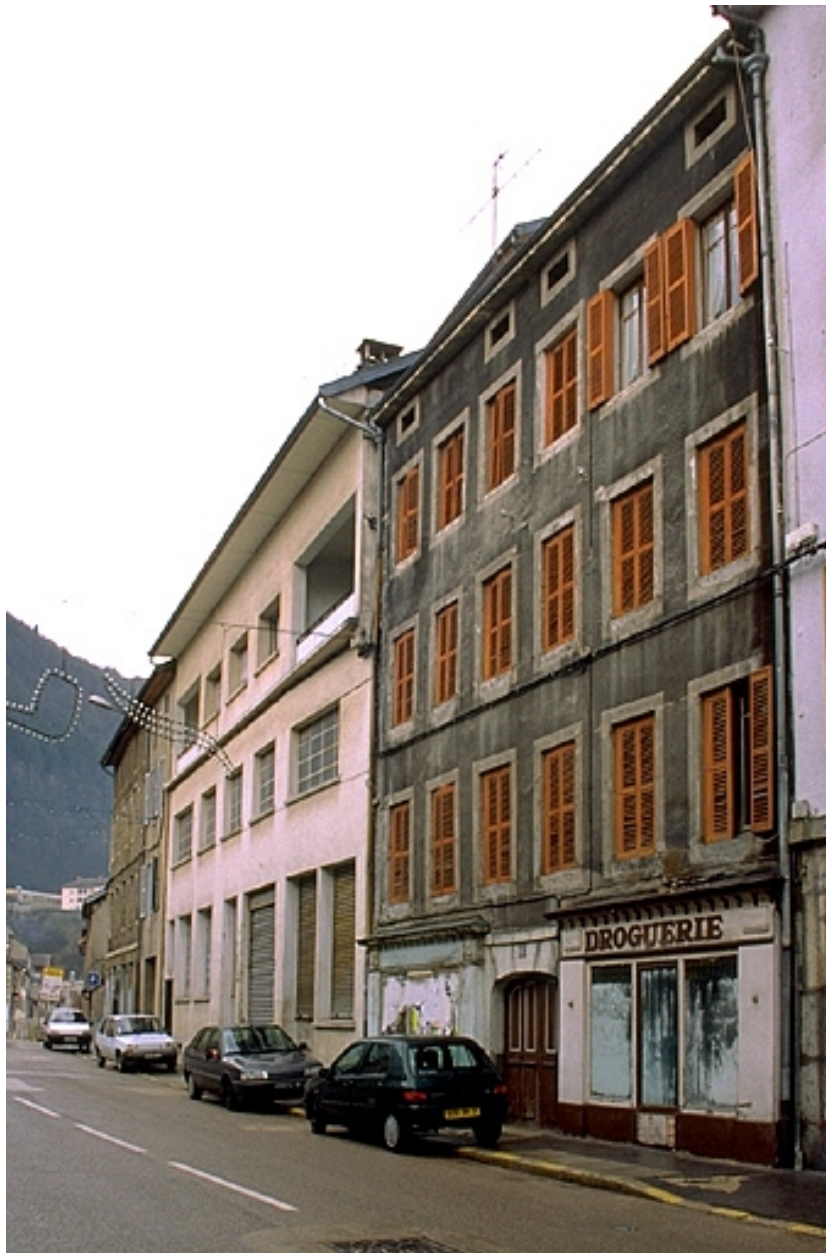
Façades postérieures de trois quarts droite.
