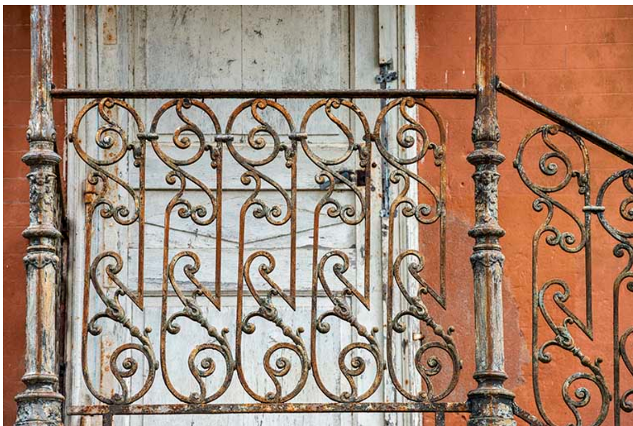
Garde-corps du perron.
