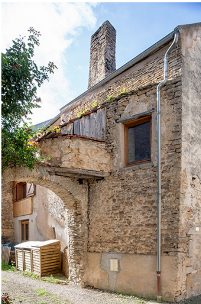
La porte charretière avec le four, depuis la rue.
