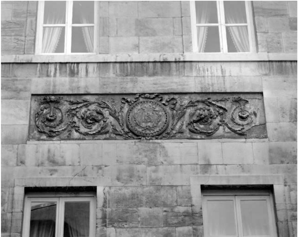
Façade sur cour : détail des décors de la partie centrale.
