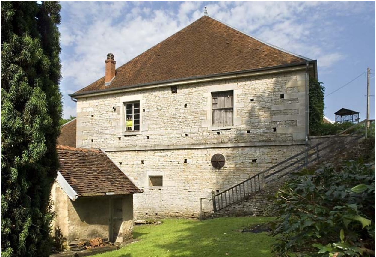
Façade ouest du haut fourneau.
