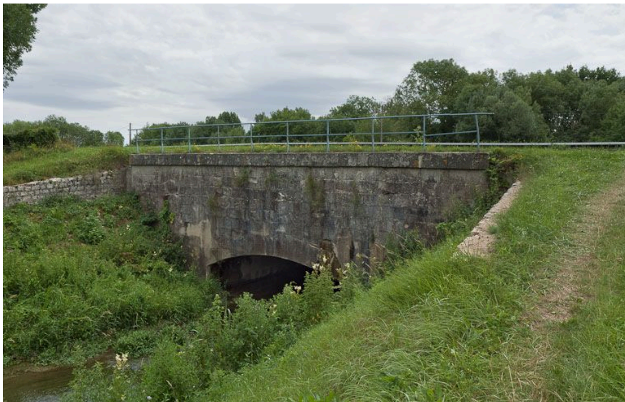
Vue de l'entrée de l'aqueduc.
