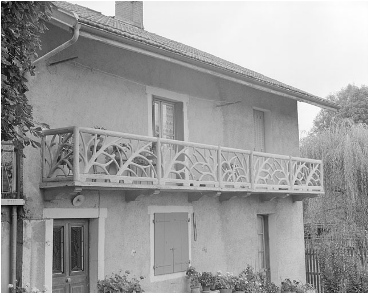
Garde-corps de balcon d'une ferme.
