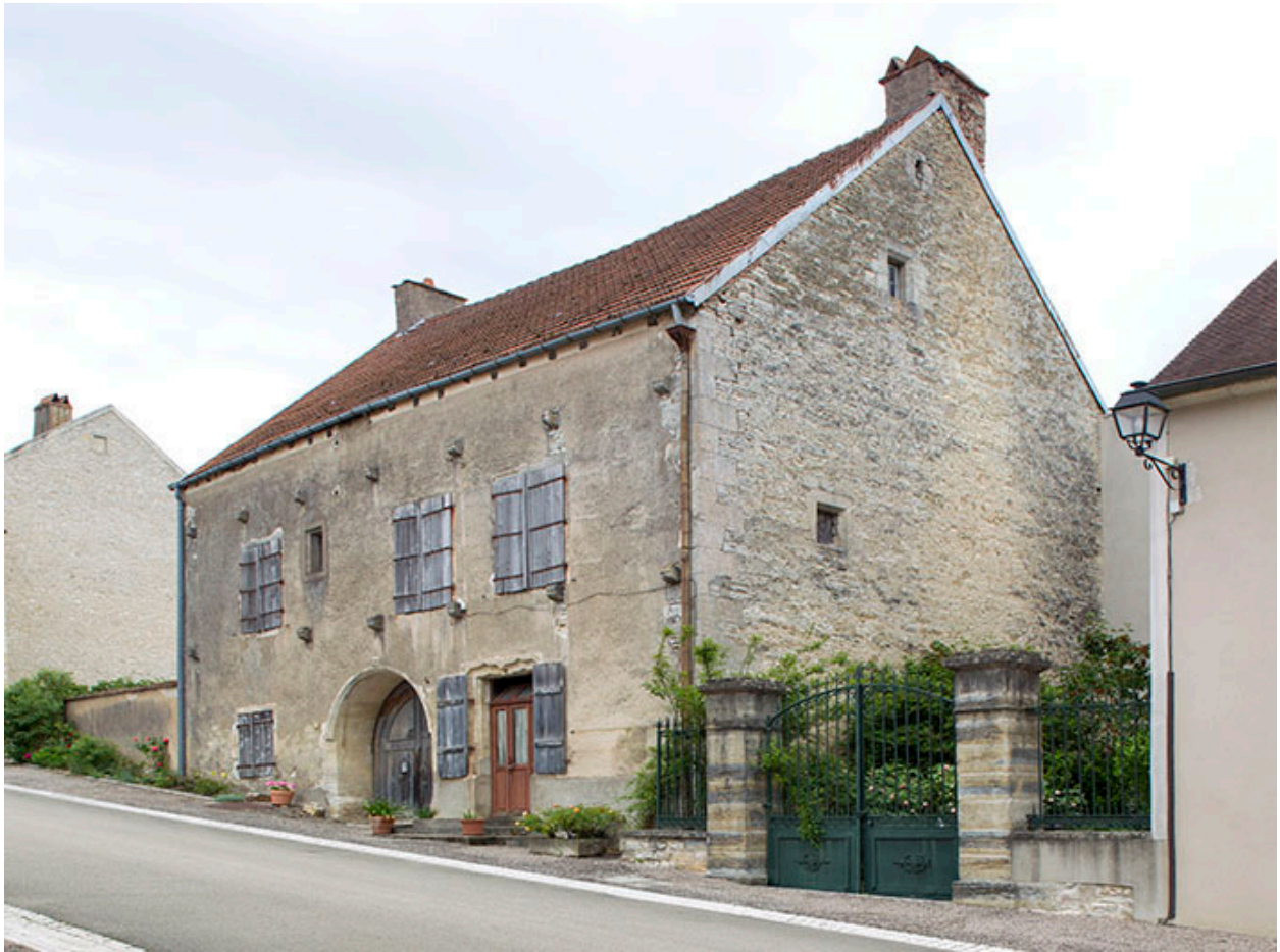
Vue générale de trois quart droite.
