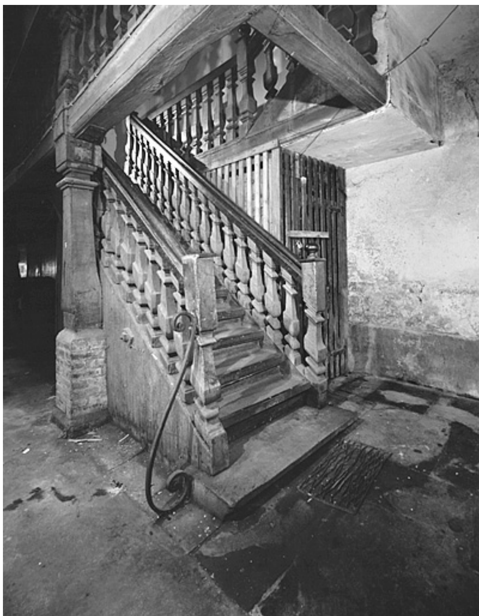
Escalier, première volée.
