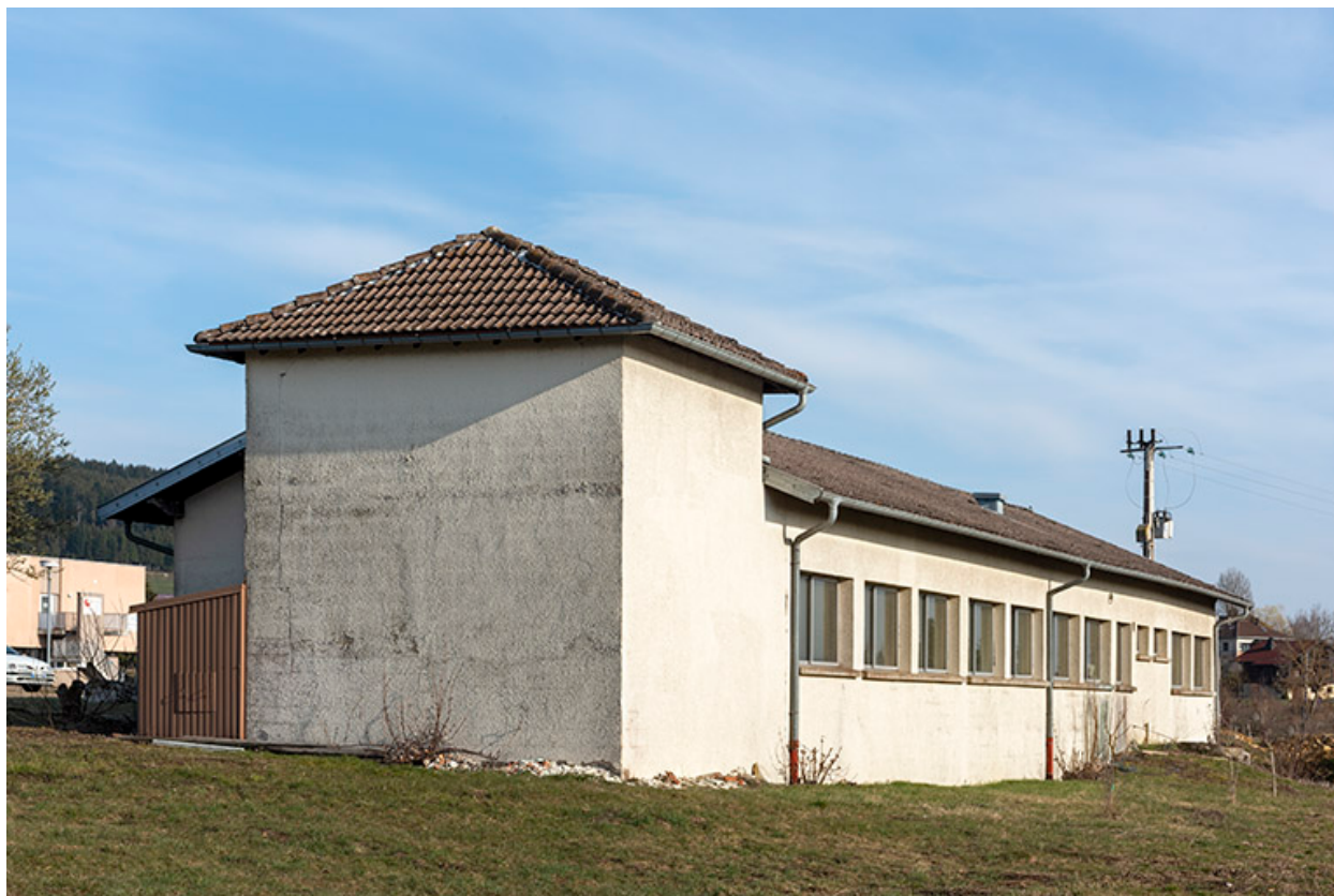
Façades postérieure et latérale gauche.
