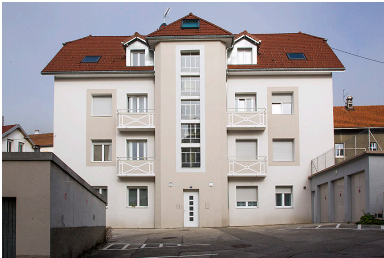
Bâtiment nord : façade antérieure.
