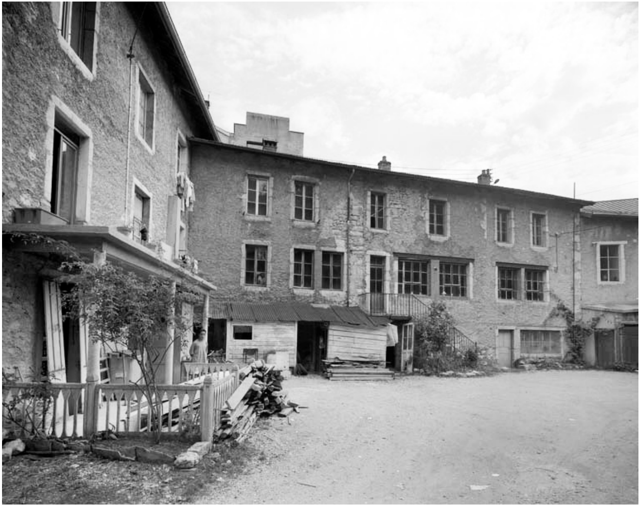
Bâtiments rue Carnot : façade antérieure de l'aile nord.
