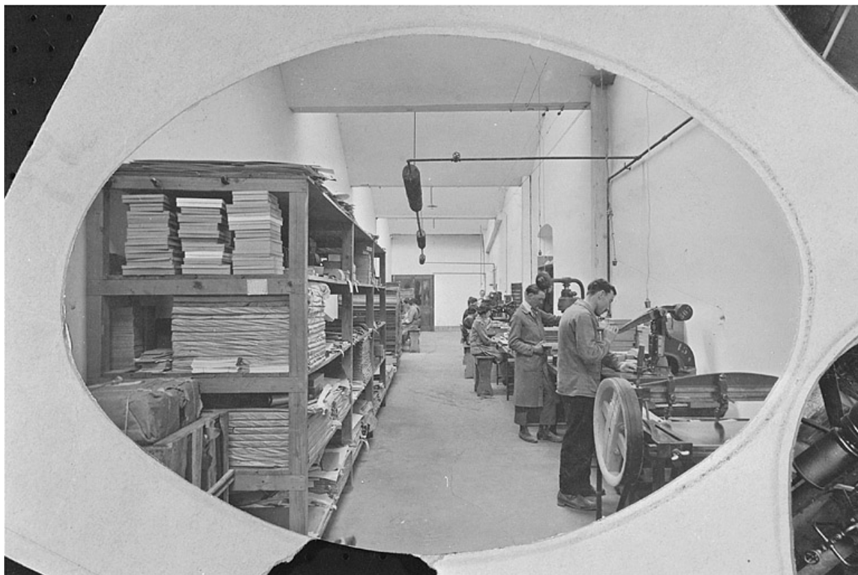
Vue ancienne de l'atelier de gainerie.
