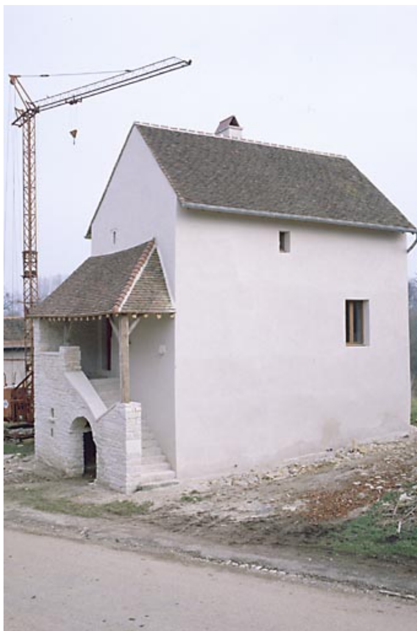
Bard-lès-Pesmes, maison de vigneron située rue Basse.
