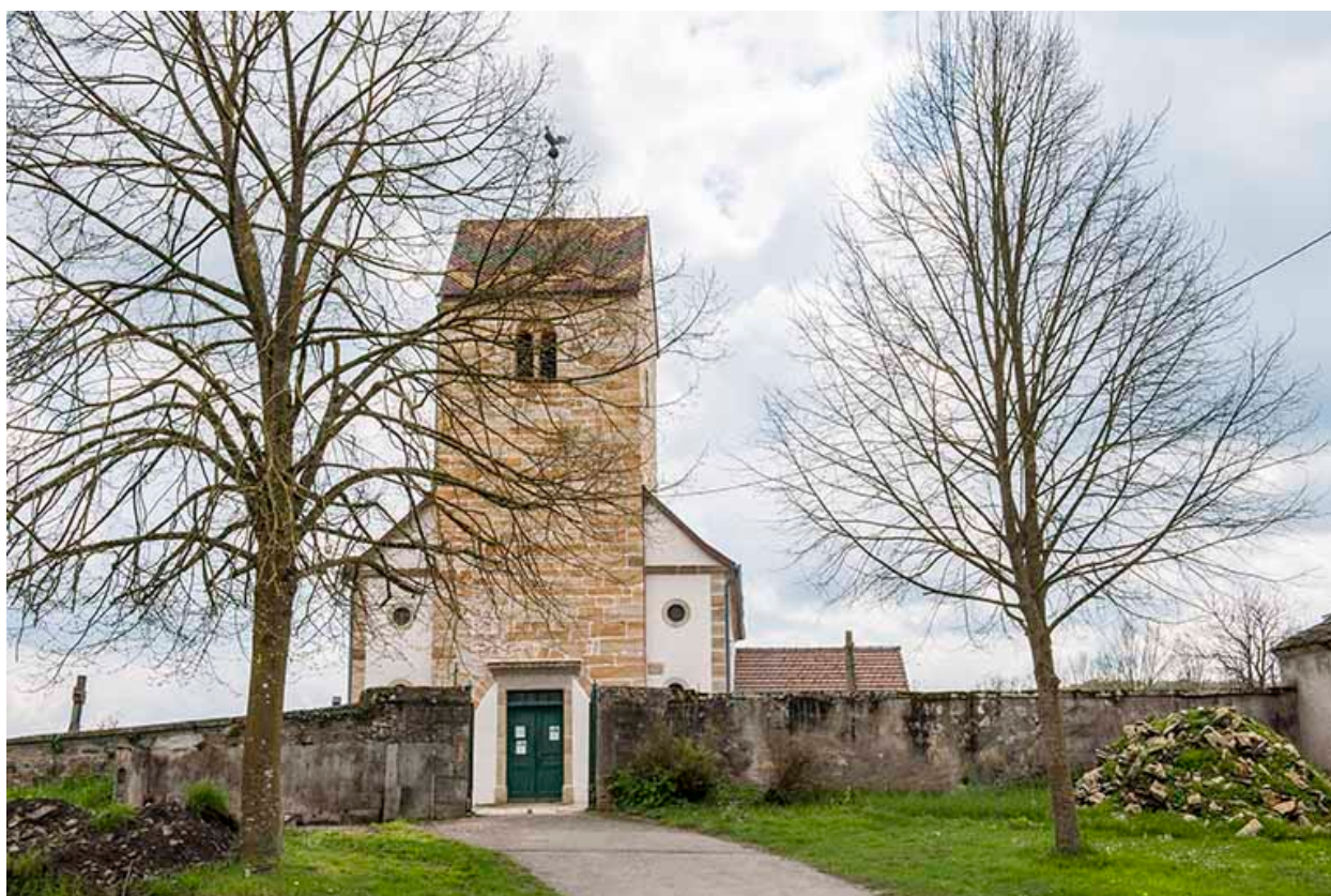
Vue depuis la route de l'Eglise.
