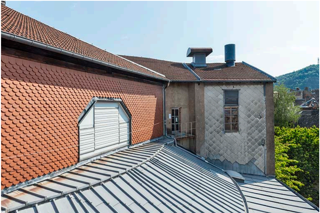
Ancien cirque (Petit et Grand Kursaal) : tambour de la fausse-coupole et corps nord-est.
