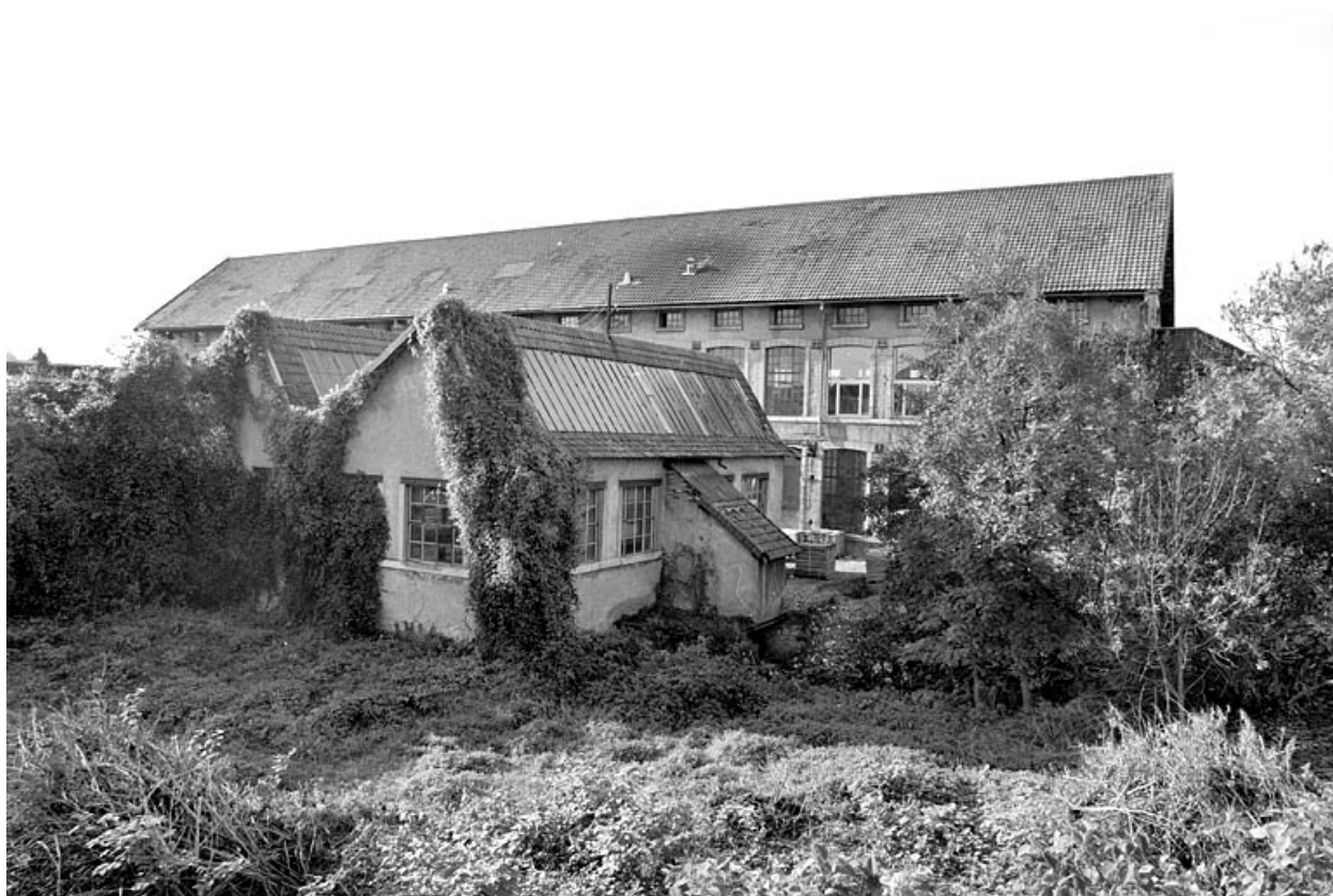
Ateliers de fabrication depuis l'est.
