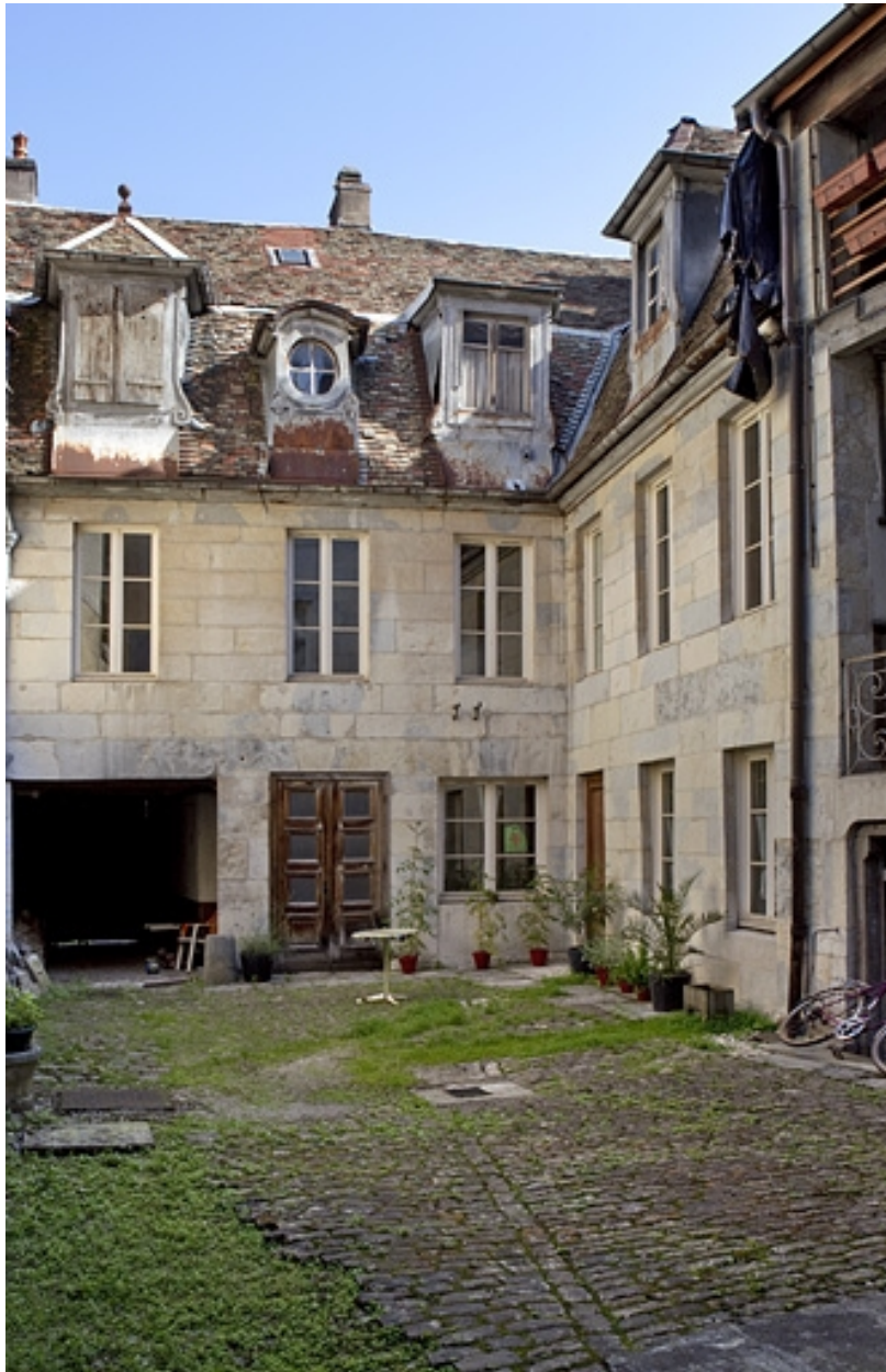
Façade antérieure du premier logis secondaire.
