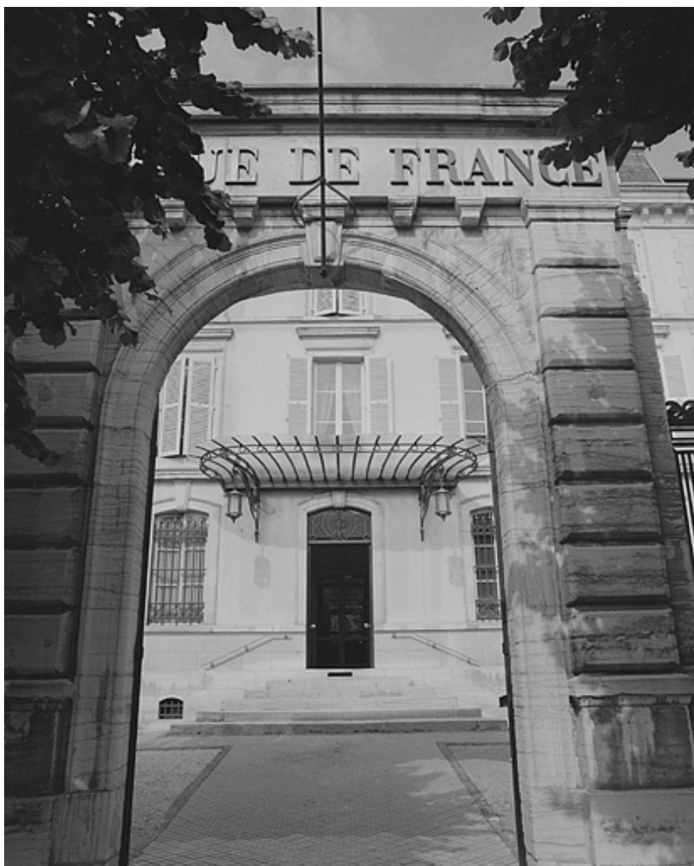
Portail d'accès à la cour.
