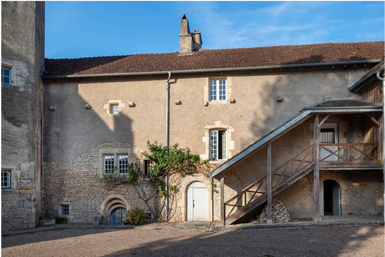
Façade est de l'aile latérale ouest, vue depuis l'est.
