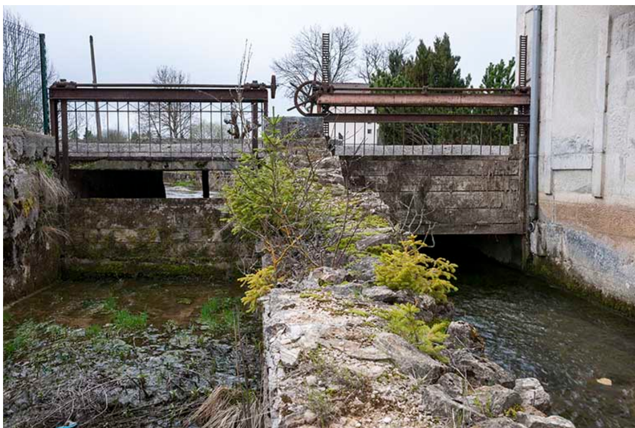
Vestiges du local des turbines.
