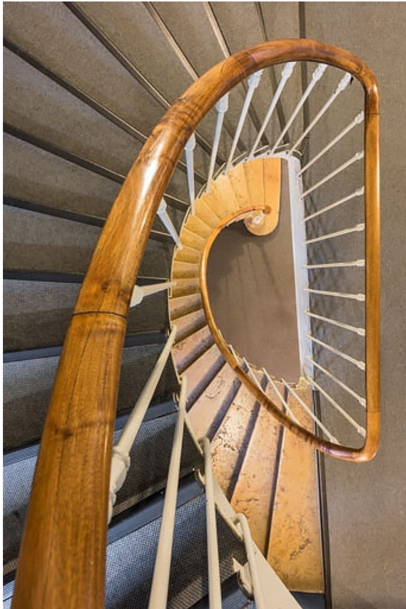
Escalier côté cour : rampe vue du dessus.
