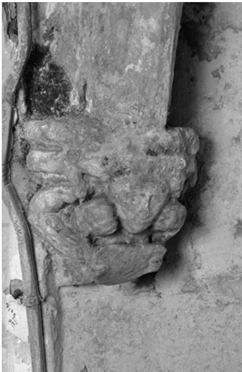
Culot du rez-de-chaussée de la tour-clocher.
