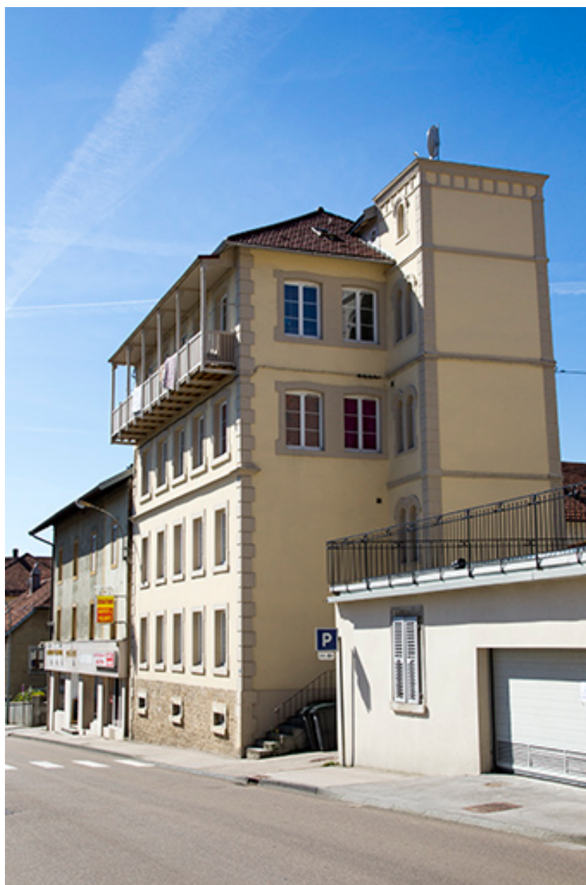
Usine : façades antérieure et latérale droite.
