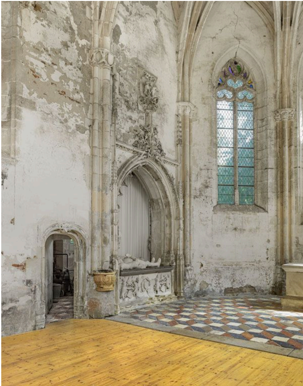
Intérieur de la chapelle : accès à la sacristie (chapelle gauche).
