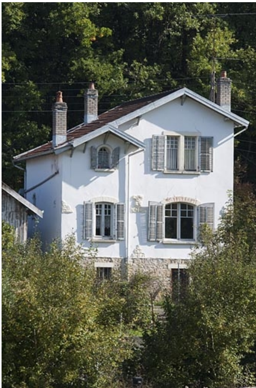
Pignon d'une maison individuelle.
