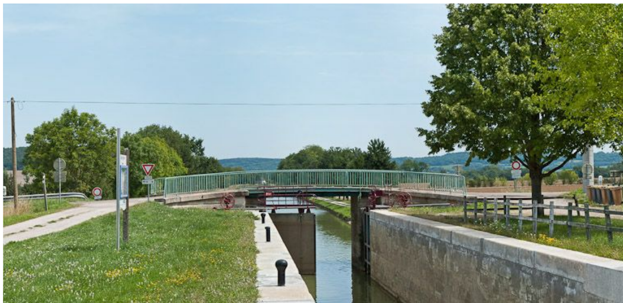
Vue du pont depuis l'amont.
