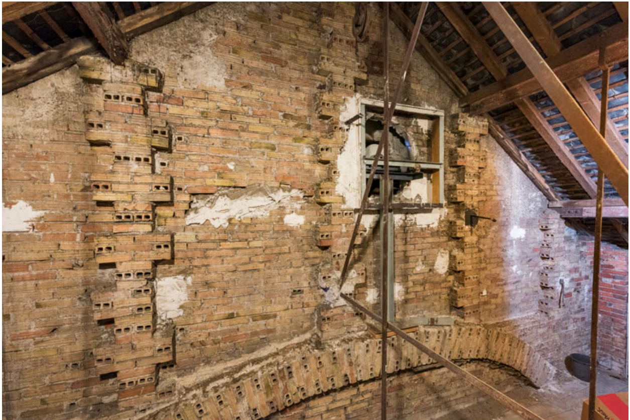
Combles : mur séparant la salle de l'ancien théâtre (vu depuis la salle).
