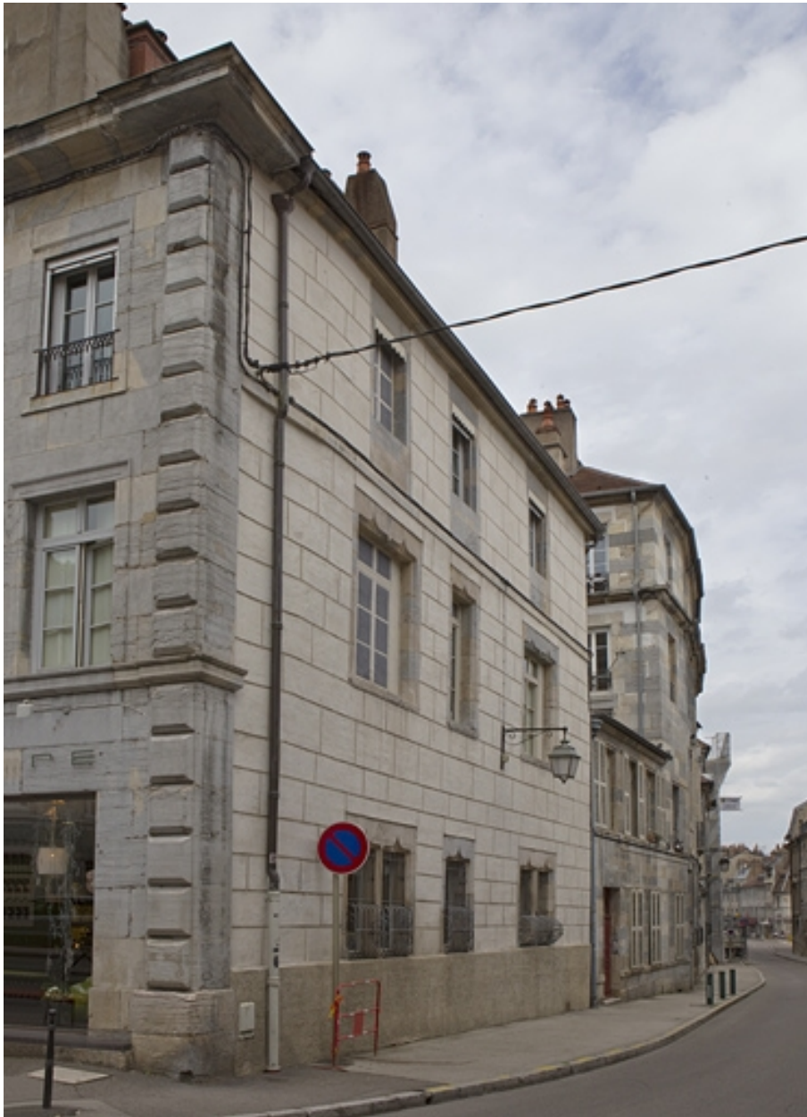
Vue d'ensemble de la façade latérale droite.
