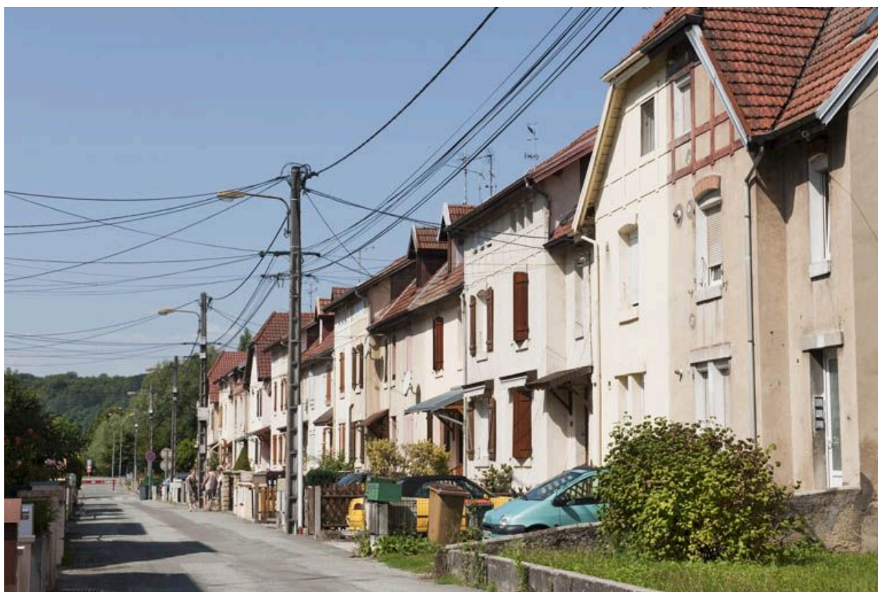
Rue de Somme. Façades sud.
