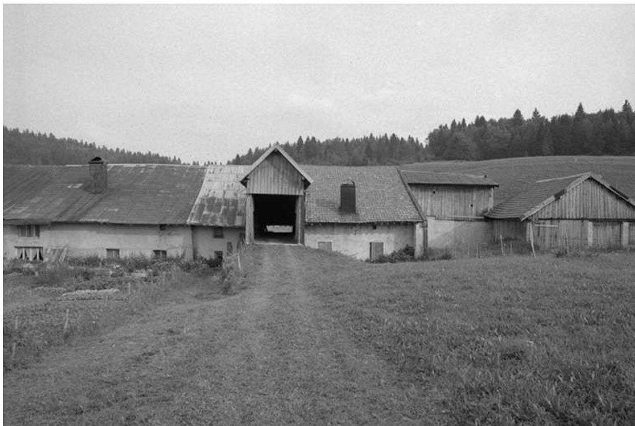
Façade postérieure avec pont de grange.
