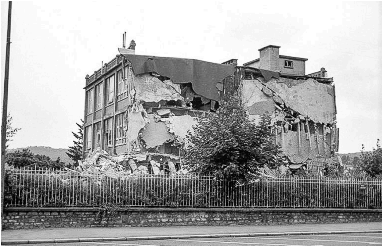
Destruction de l'usine, 22 août 1993 : ateliers (6a, 2a) vus depuis le nord.
