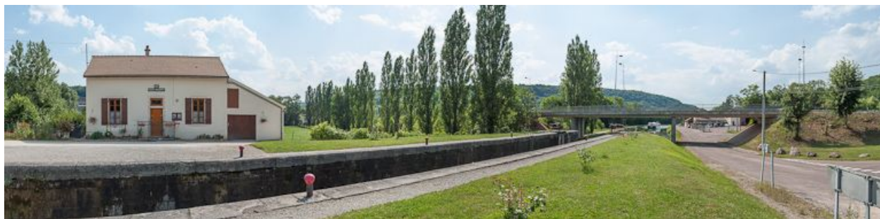
Vue d'ensemble du site d'écluse.
