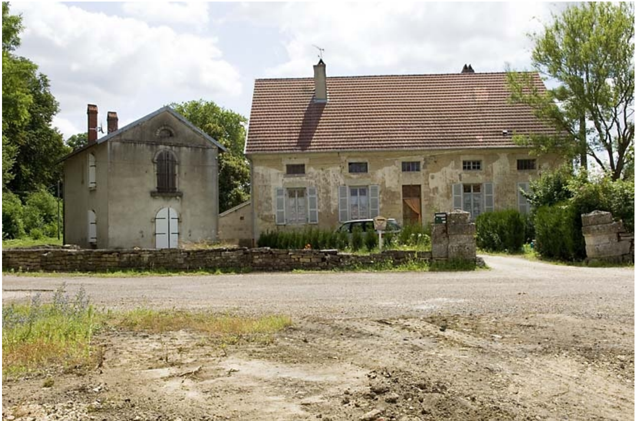
Bureau (?) et logement patronal.
