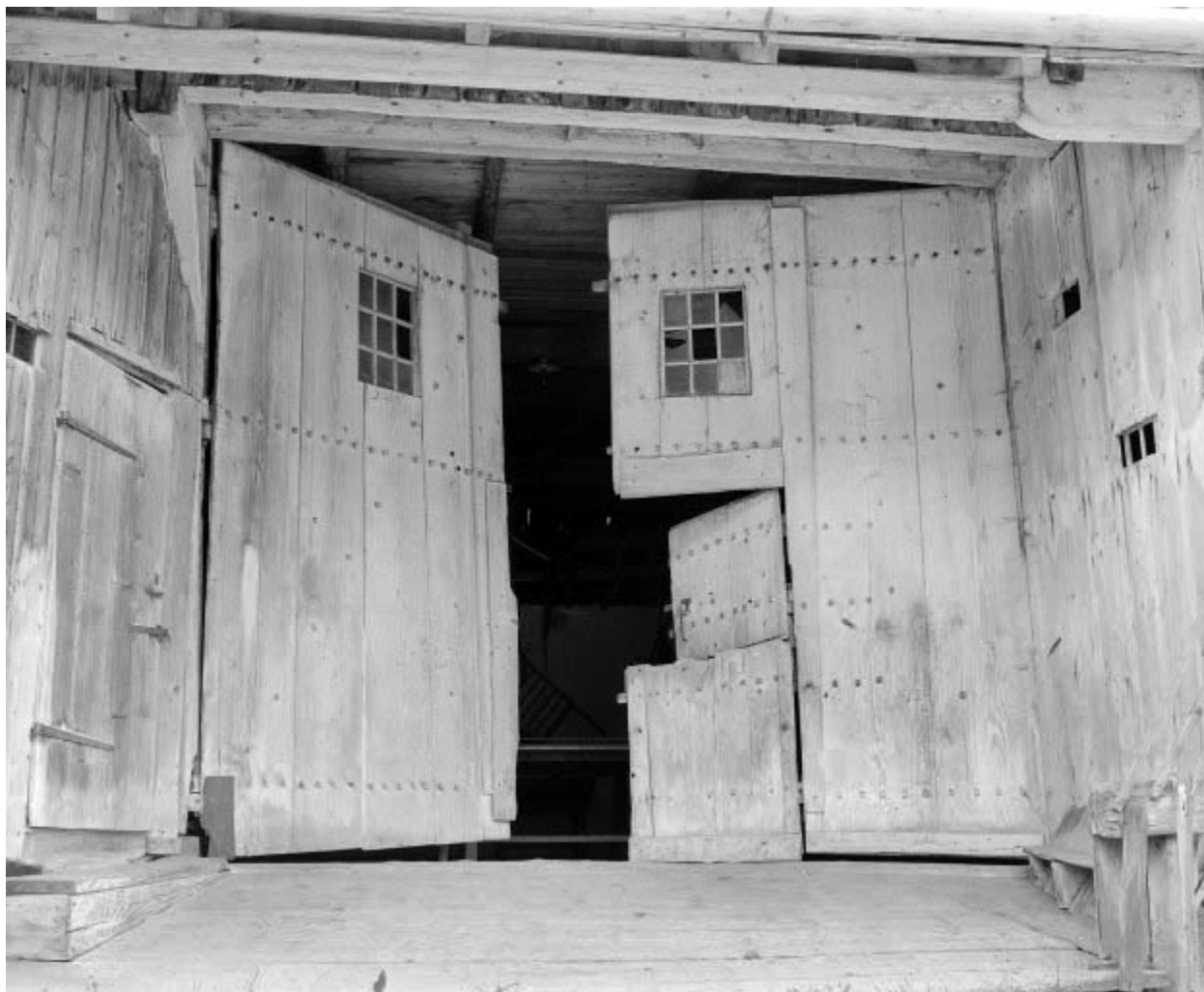
Façade postérieure en 1977 : porte de grange droite entrouverte.
