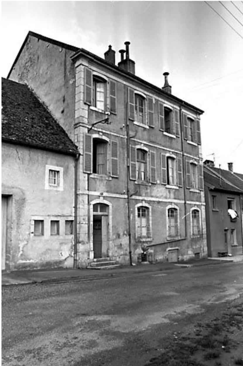
Maison située 28 rue du Seult.
