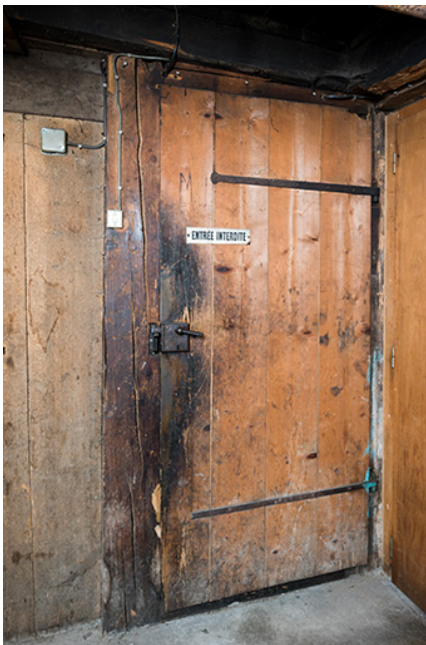
Intérieur : porte de l'atelier.
