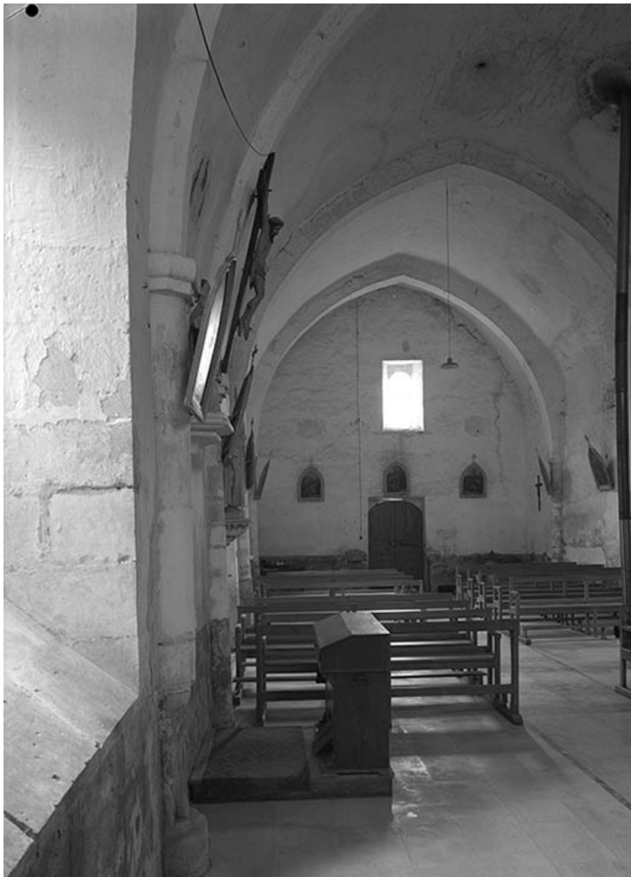
Vue est-ouest de la nef, avec voûte en berceau brisé et doubleaux.
