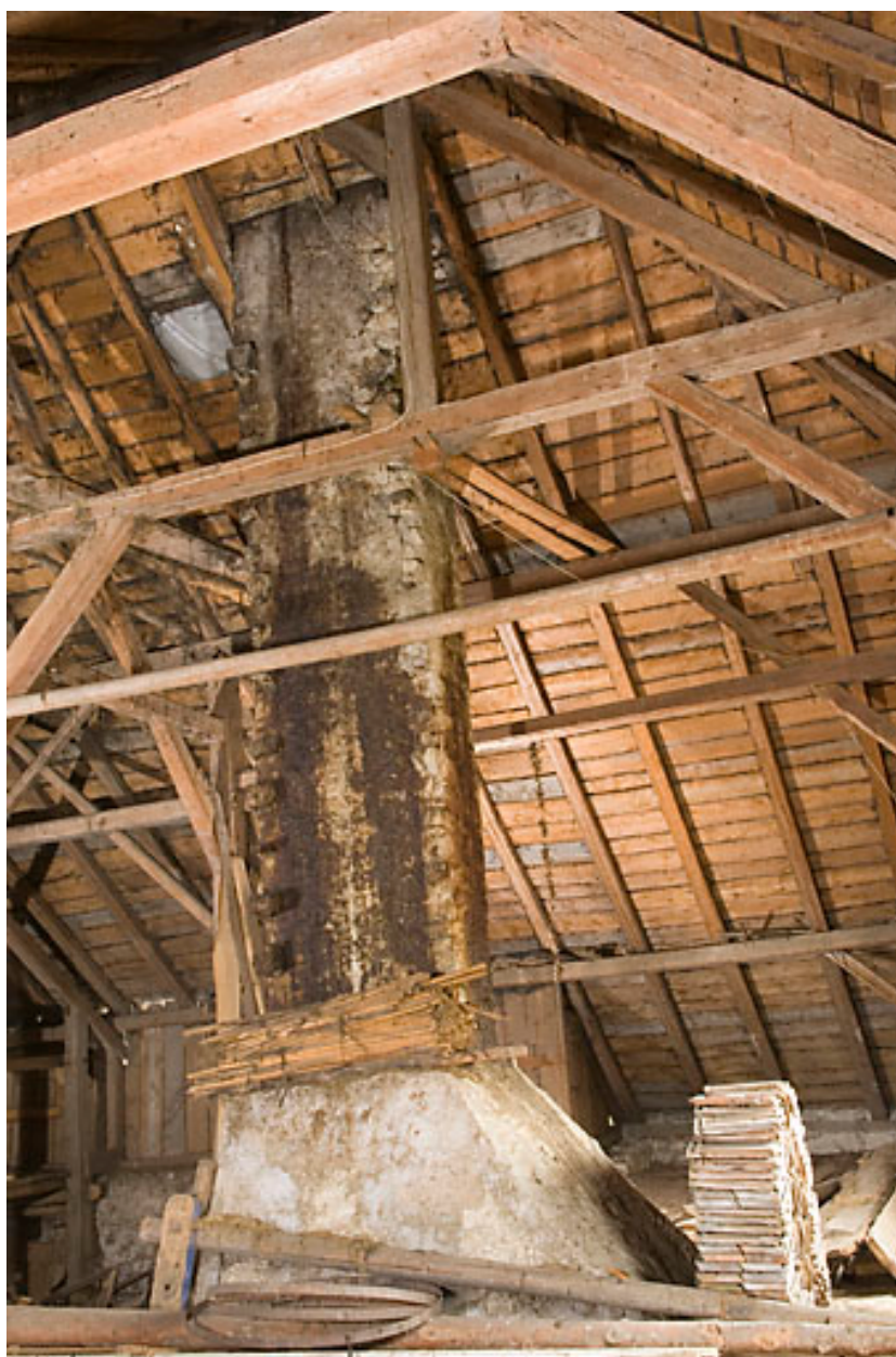
Grange : conduit de cheminée.
