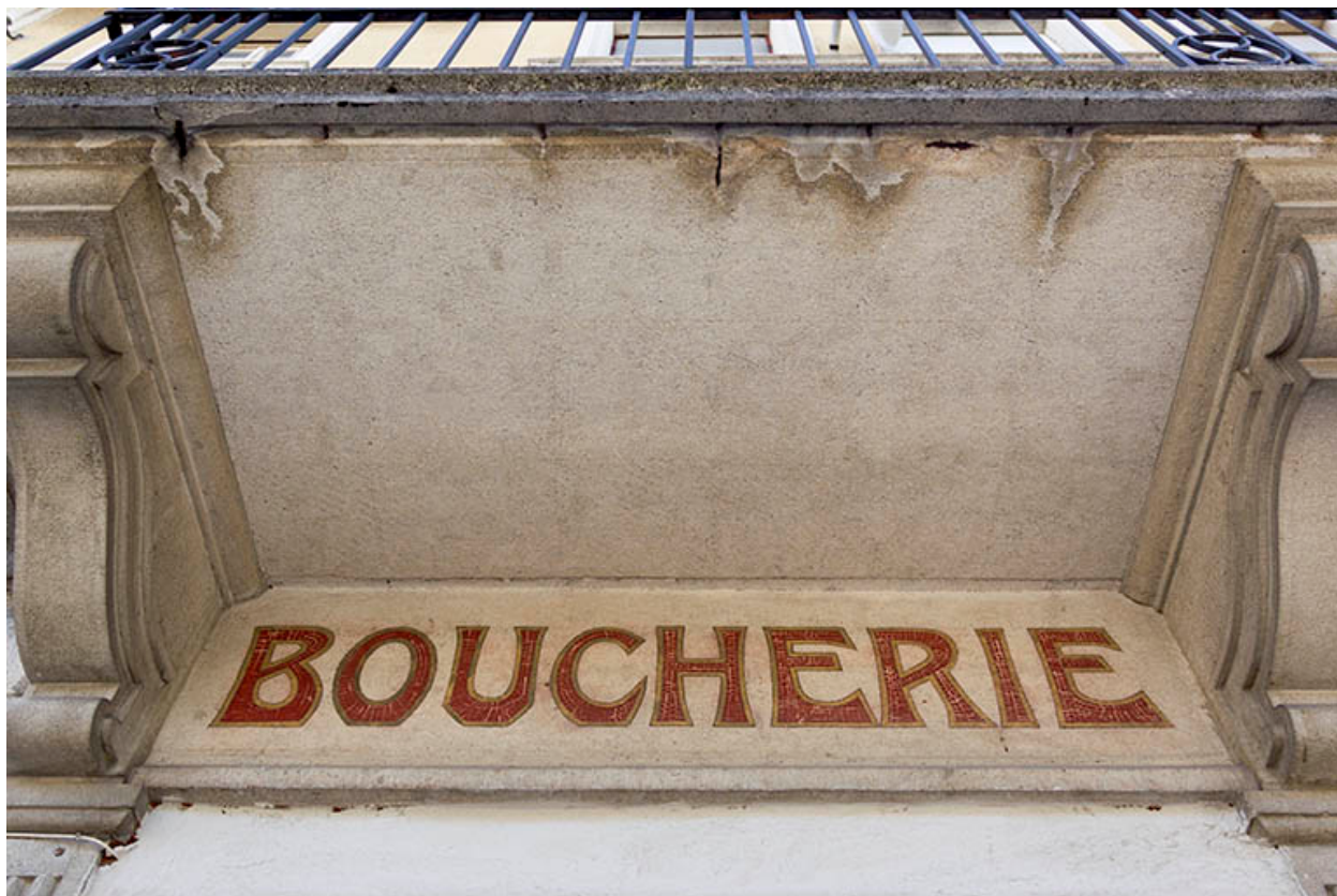
Façade antérieure : partie gauche de l'enseigne peinte.
