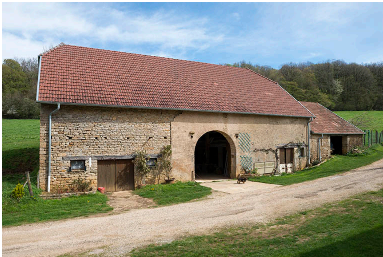
façade antérieure de la grange.
