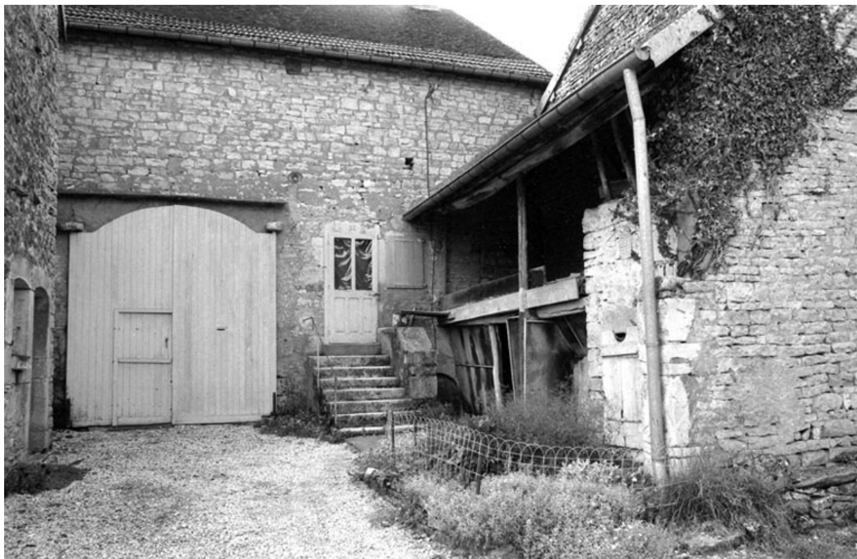
Le bâtiment en fond de cour.
