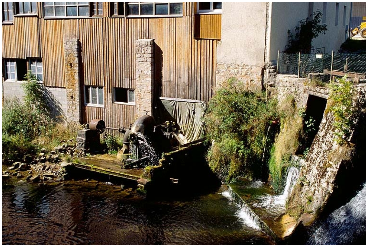
Moulin Choudet : la turbine et le barrage.
