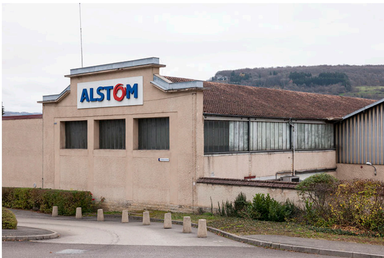
Mur-pignon de l'ancienne hall ouest.
