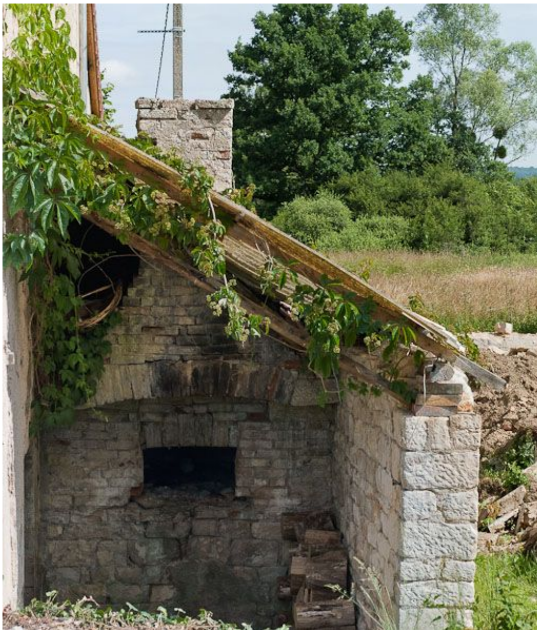
Vue du four à pain.
