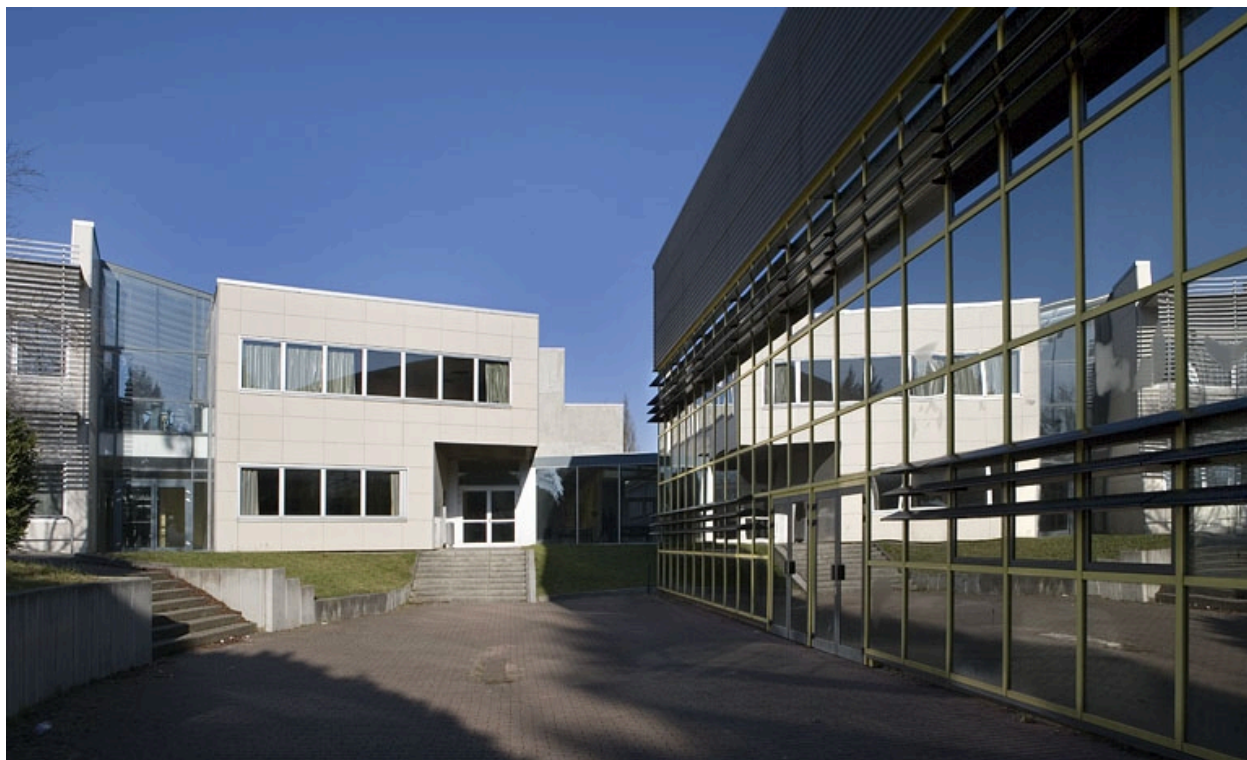
Vue de la façade antérieure bâtiment B.
